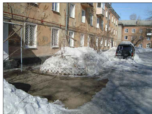
Тротуарное покрытие входа в подъезд
